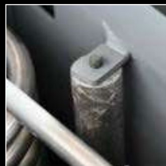
Anodo sacrificale in magnesio per una maggiore protezione della caldaia
