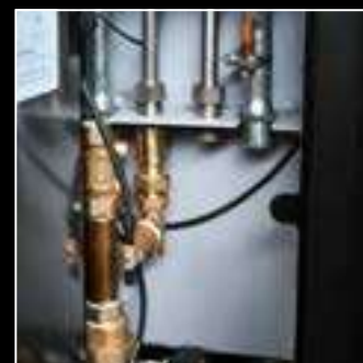
Attacchi caldaia facilmente collegabili mediante tubi flessibili
