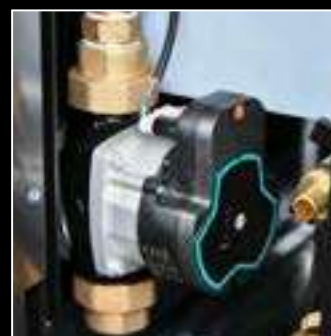
Pompa per circuito di riscaldamento
